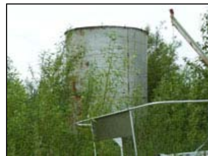
View of the Abandoned AVEC Property
